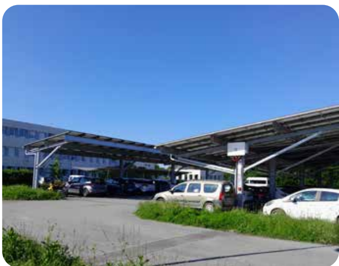
Travaux d'aménagement d'ombrières avec des panneaux photovoltaïques au collège François-Villon
